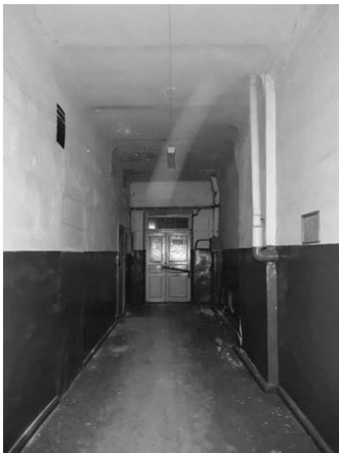
23. Выявленный объект культурного наследия «Полюстровская трамвайная подстанция», Санкт-Петербург, Полюстровский пр., д.4, лит.А. Коридор (пом. 16, 2-й эт.)
