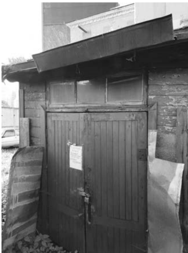
4. Выявленный объект культурного наследия «Полостровская трамвайная подстанция», Санкт-Петербург, Полостровский пр., д.4, лит.А. Фрагмент 1-эт.пристройки к торцевому северному фасаду.
