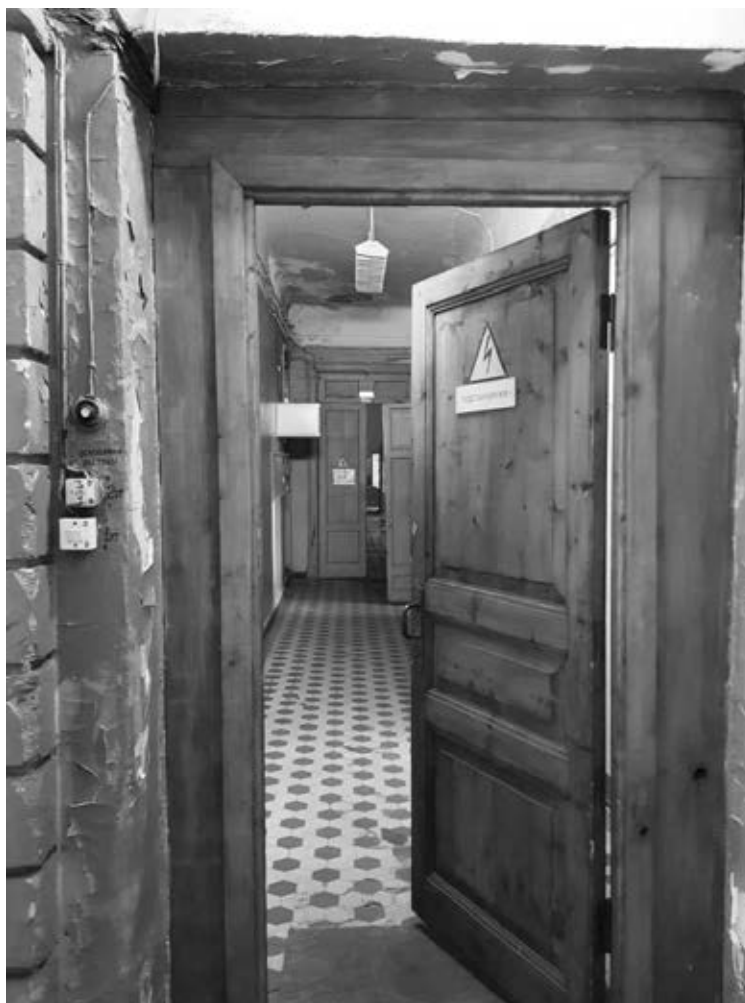
15. Выявленный объект культурного наследия «Полюстровская трамвайная подстанция», Санкт-Петербург, Полюстровский пр., д.4, лит.А. Коридор (пом.4, 1-й эт.).
