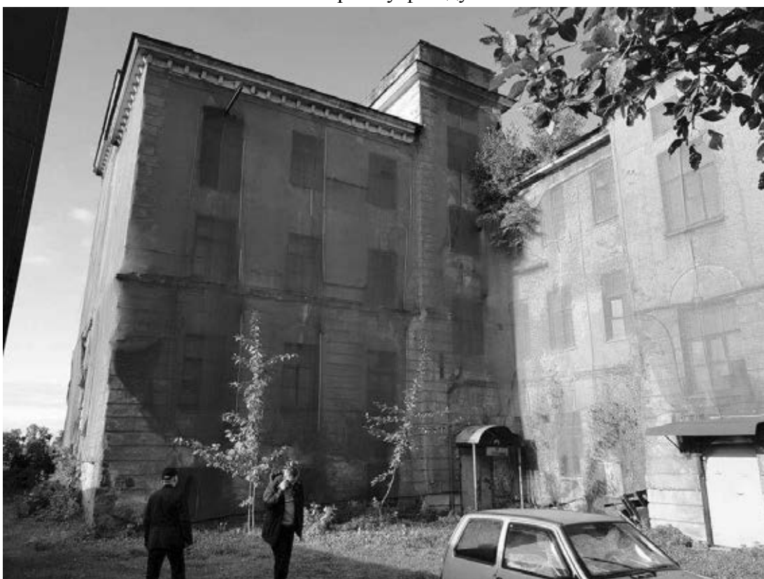
5. Выявленный объект культурного наследия «Полостровская трамвайная подстанция», Санкт-Петербург, Полостровский пр., д.4, лит.А. Фрагмент восточного фасада.
