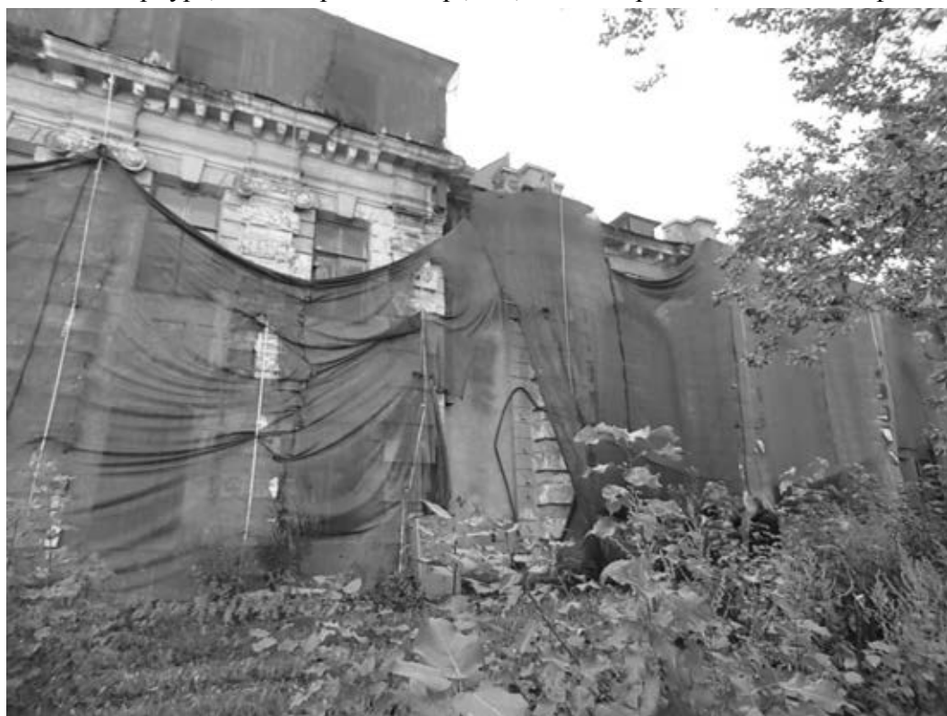
10. Выявленный объект культурного наследия «Полюстровская трамвайная подстанция», Санкт-Петербург, Полюстровский пр., д.4, лит.А. Фрагмент западного фасада.
