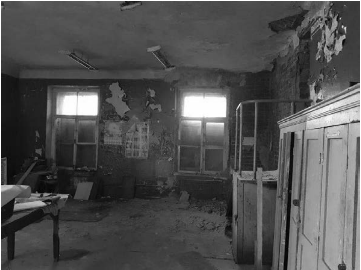
21. Выявленный объект культурного наследия «Полюстровская трамвайная подстанция», Санкт-Петербург, Полюстровский пр., д.4, лит.А. Пом. 19, 2-й эт.
