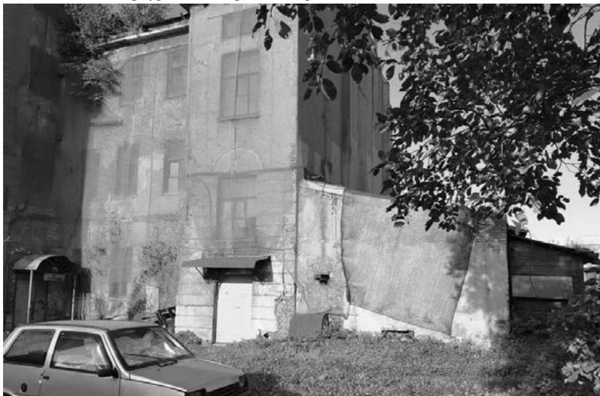
3. Выявленный объект культурного наследия «Полуостровская трамвайная подстанция», Санкт-Петербург, Полуостровский пр., д.4, лит.А. Северная часть здания с 1-эт. пристройкой к торцевому фасаду.
