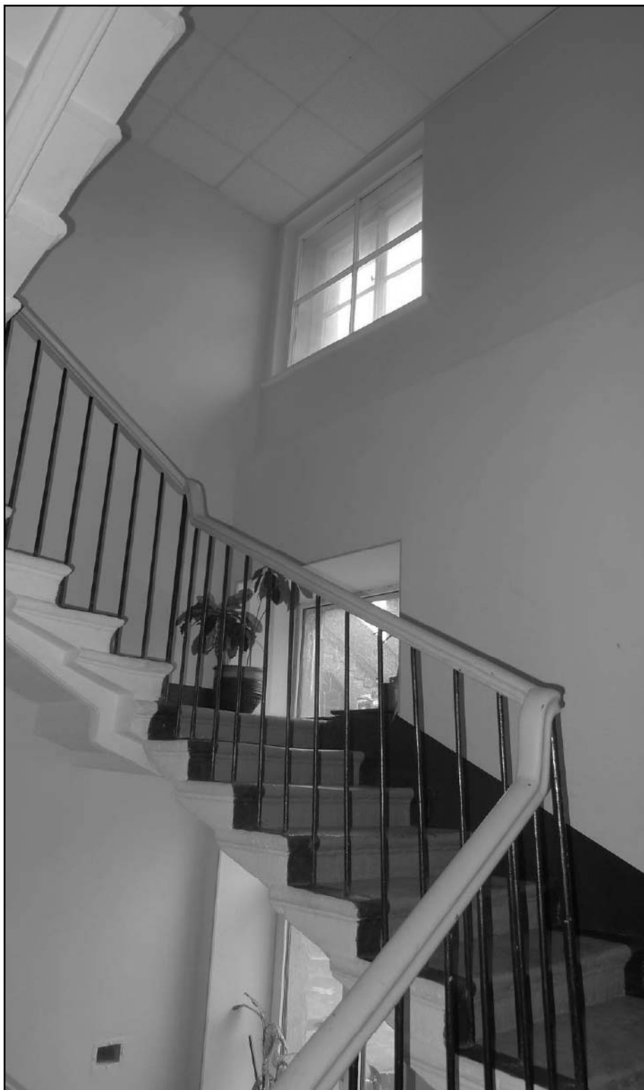
Фото 19. Общий вид лестничной клетки. Окна ОК-6, ОК-7
