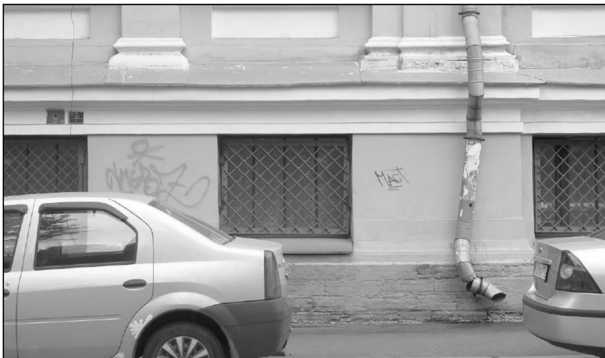
Фото 7. Лицевой фасад. Фрагмент. Окна ОК-1. Окна заменены на металлопластиковые
