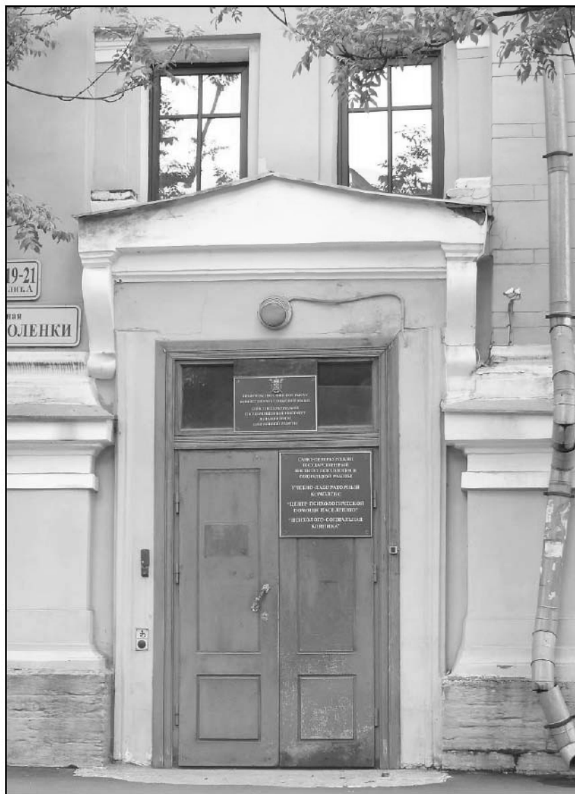
Фото 5. Лицевой фасад. Фрагмент. Окна ОК-3.
