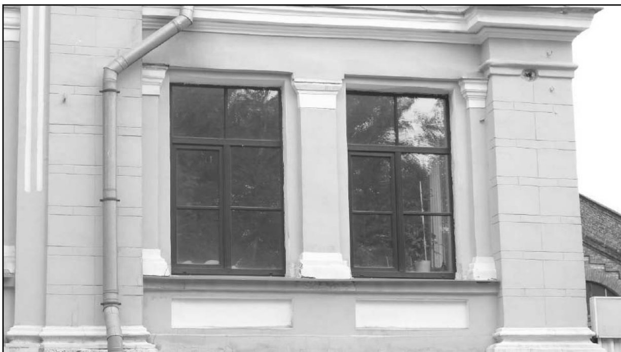
Фото 4. Лицевой фасад. Фрагмент. Окна ОК-4. Окна заменены на металлопластиковые
