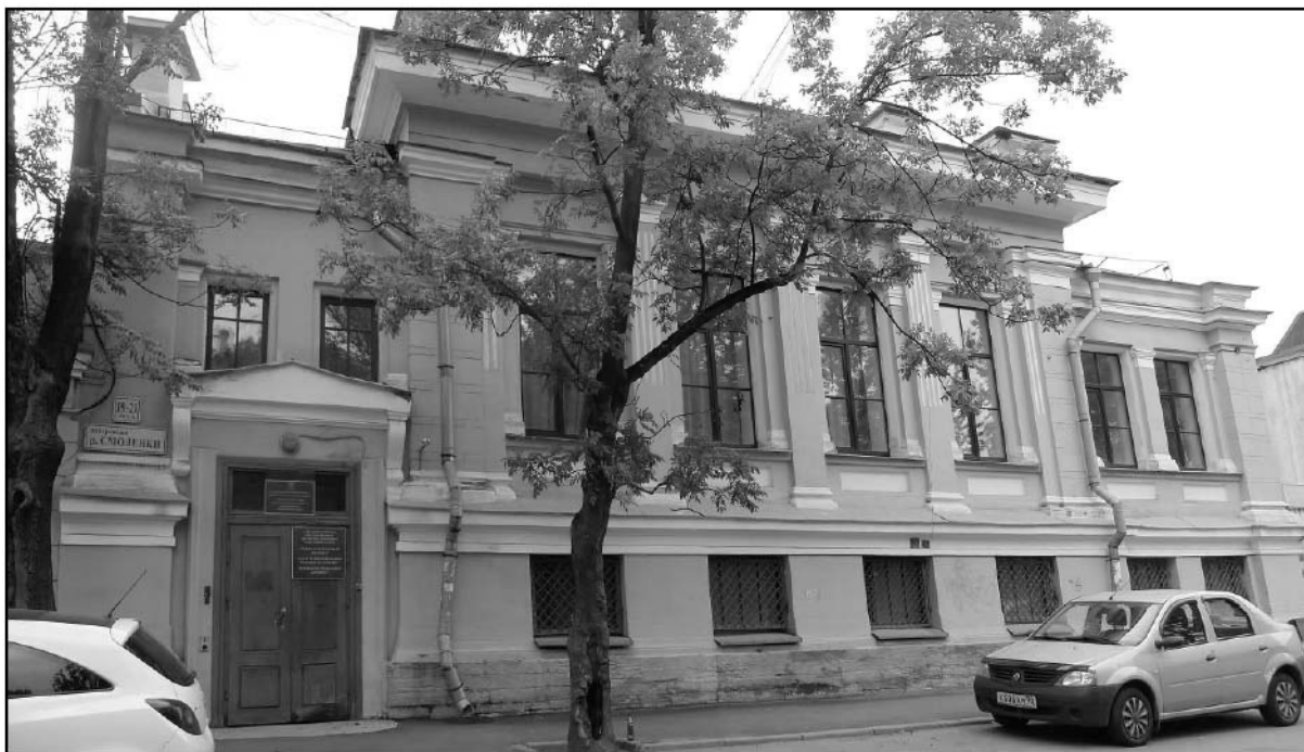
Фото 1. Южный лицевой фасад по наб. р. Смоленки. Вид с Юга
