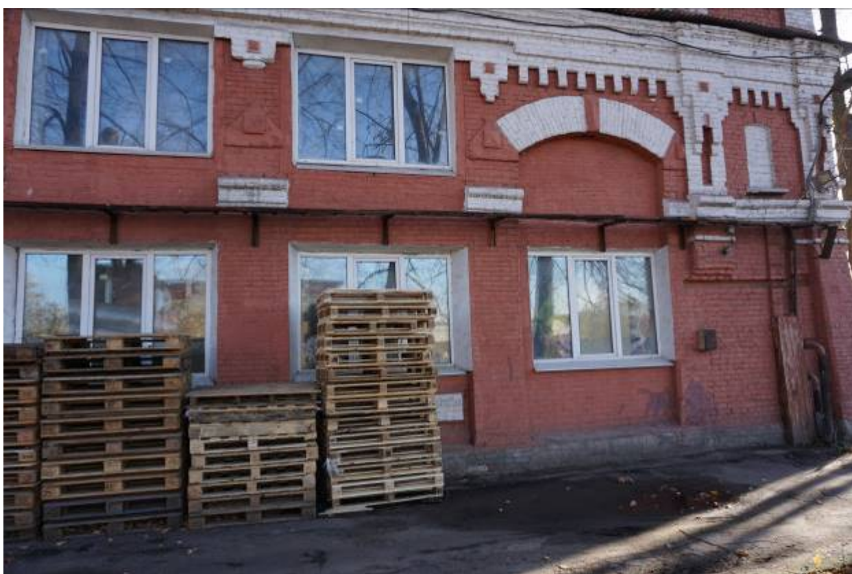
Фото 8. Фрагмент западного фасада здания.
