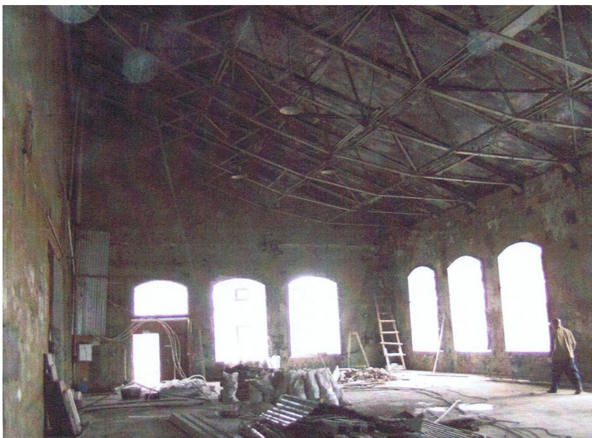
37. Металлические серповидные фермы (северная часть) до ремонта, сейчас защиты подвесным потолком. — Архив КГИОП.
