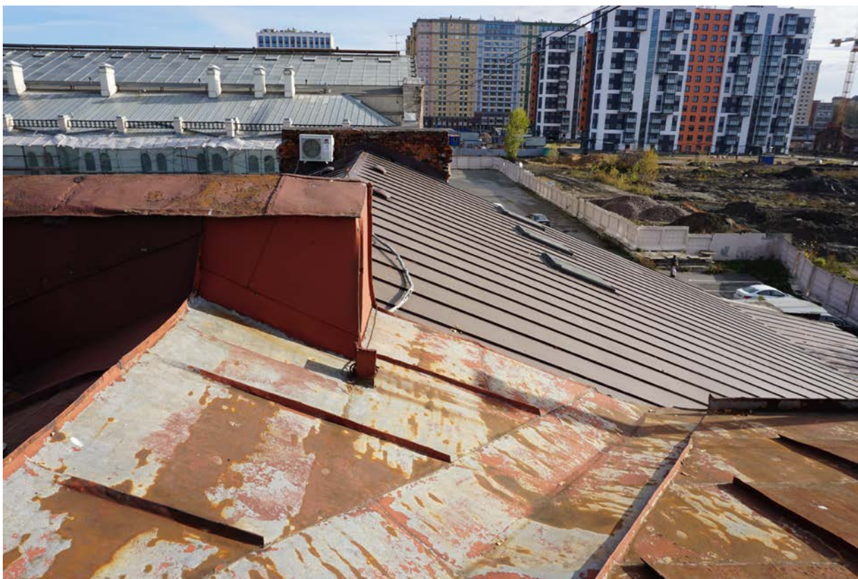
Фото 18. Металлическое покрытие кровли в южной части здания.
