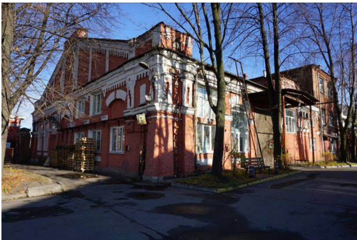
Фото 9. Западный и южный фасады здания.
