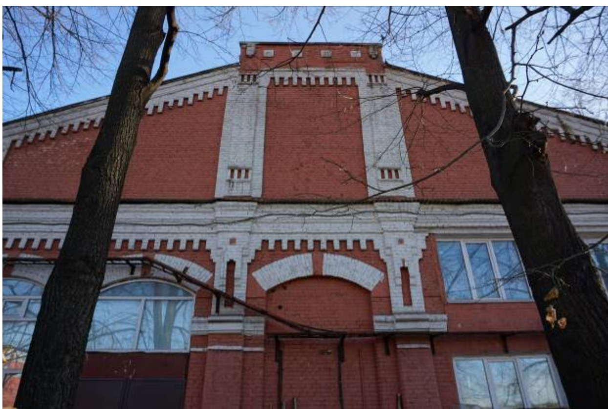
Фото 6. Фрагмент западного фасада здания.
