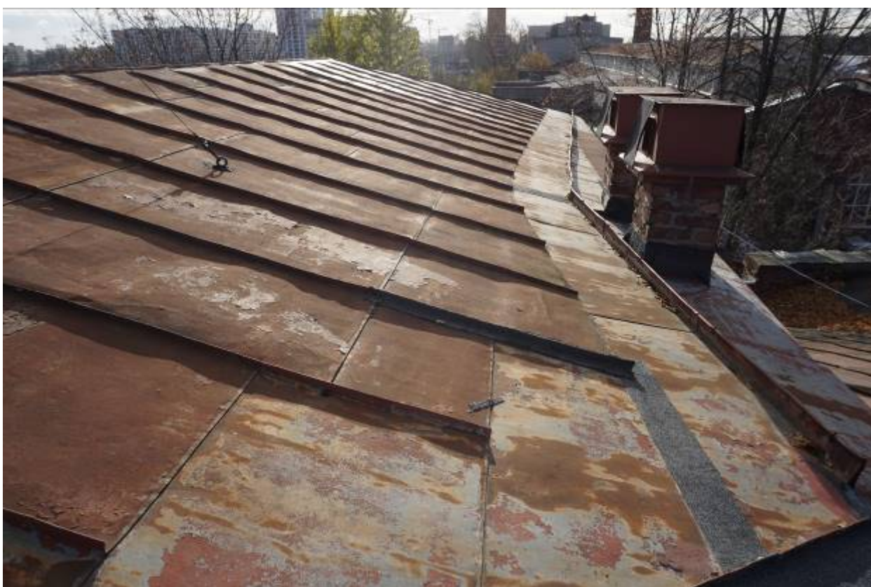
Фото 19. Металлическое покрытие кровли в северной части здания.
