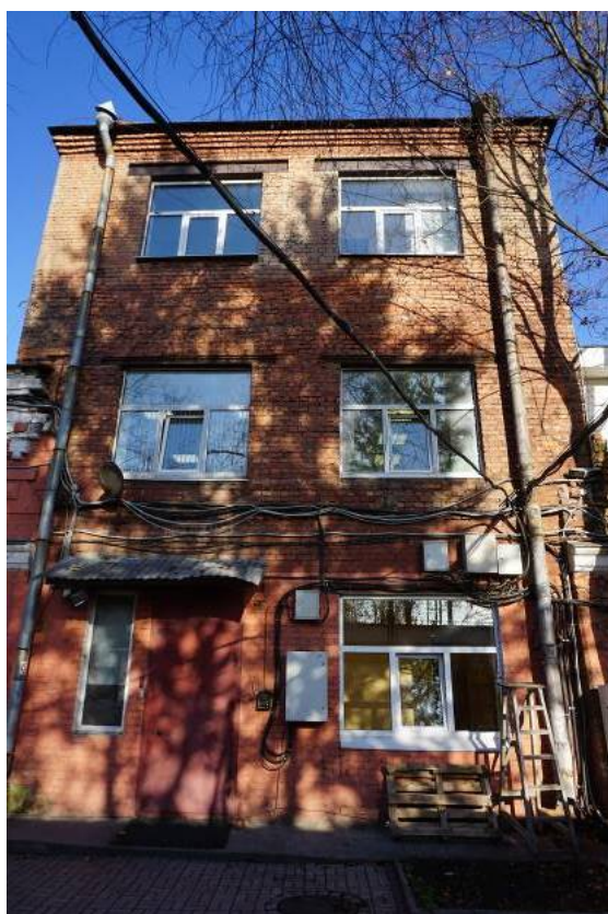
Фото 12. Фрагмент южного фасада здания.
