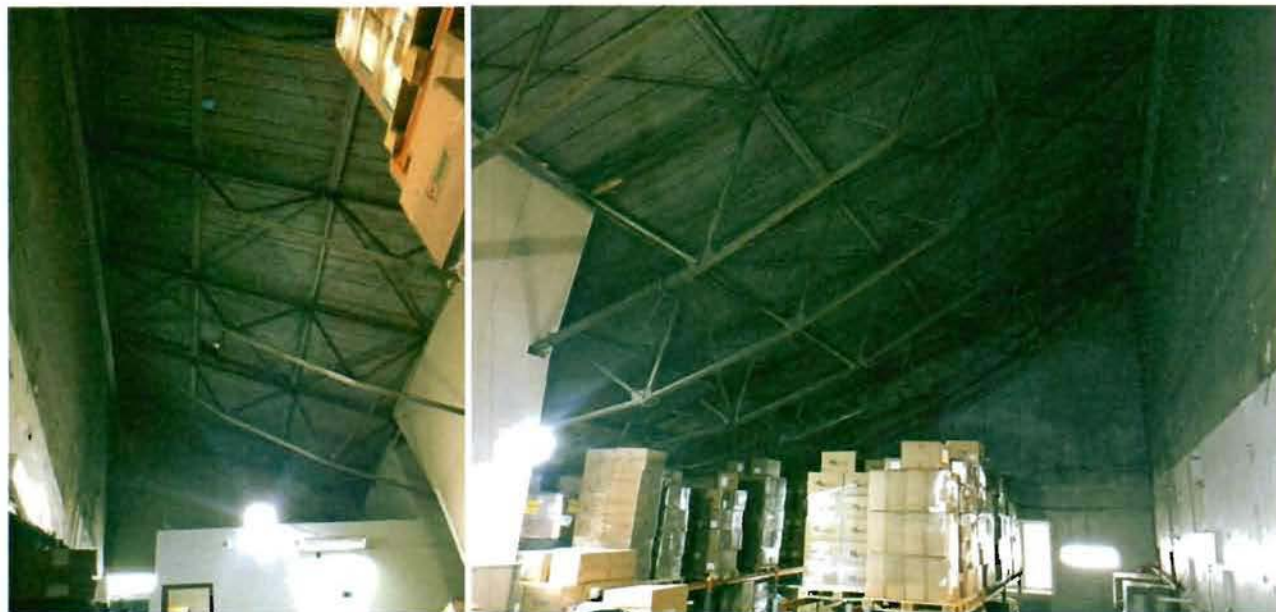
13, 14. Металлические фермы перекрытий складских помещений.
