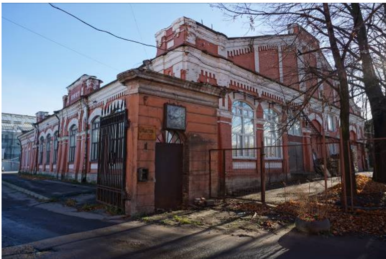
Фото 5. Северный и западный фасады здания.
