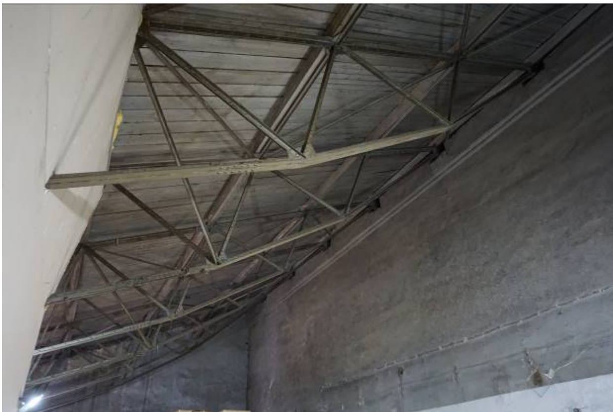
Фото 16. Серповидные металлические фермы в юго-западной части здания.
