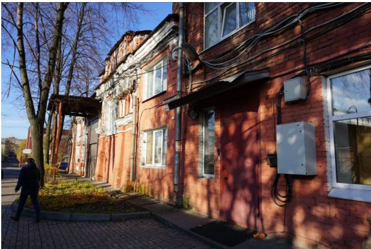
Фото 14. Фрагмент южного фасада здания.
