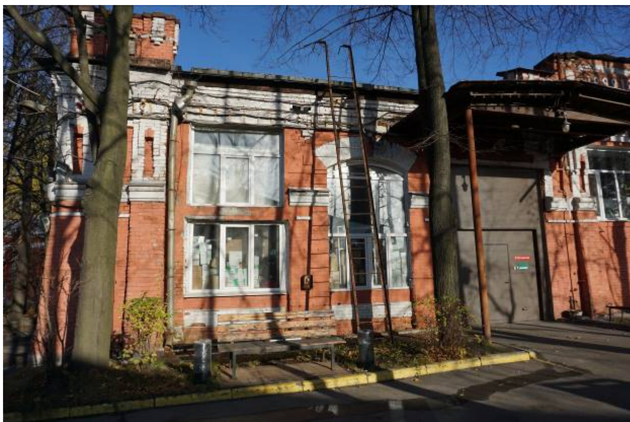
Фото 10. Фрагмент южного фасада здания. Вид на оконные проемы и дверной проем с козырьком.
