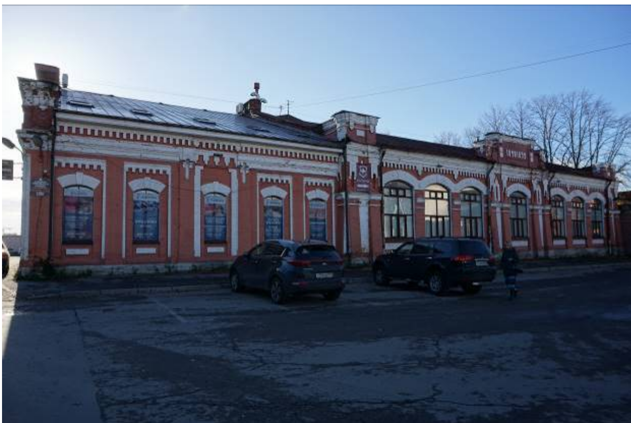
Фото 3. Общий вид северного фасада здания.
